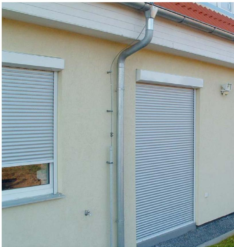
**hapa** Vorbaurollladen zeichnen sich durch unterschiedliche Gestaltungsmöglichkeiten und hochwertige Verarbeitung aus. Die Auswahl verschiedener Rolladenprofile wird durch eine große Palette an verfügbaren Farben für den ganz individuellen Charakter des Hauses ergänzt.
