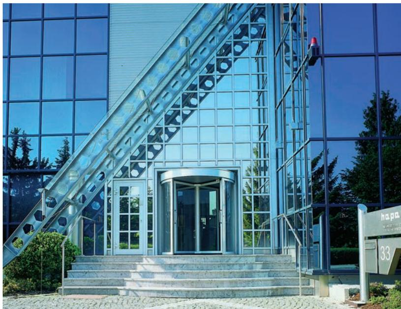
Die komplexen Beschichtungssysteme reflektieren die langwelligenen Infrarotstrahlen der auftreffenden Sonnenstrahlung, welche maßgeblich für das Aufheizen der Innenräume verantwortlich sind.
